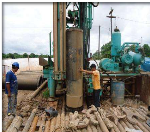
Fijación de la tubería de 25"Ø para el sellado sanitario
