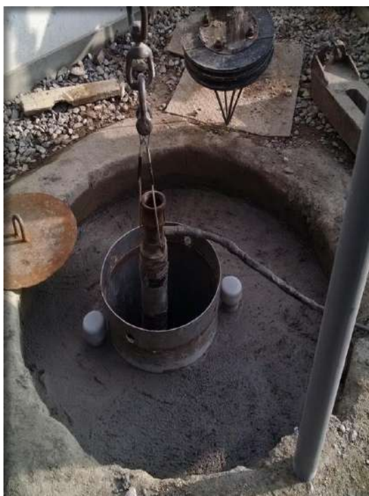
Sellado sanitario e instalación de bomba
