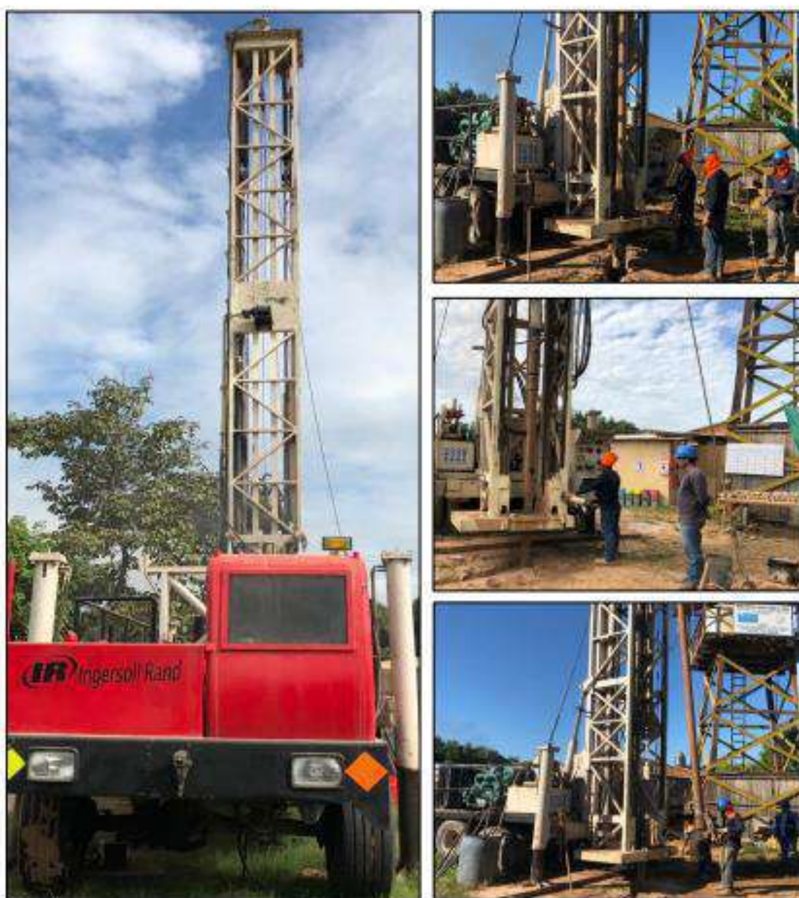
Vista de los trabajos de Perforación del pozo tubular
