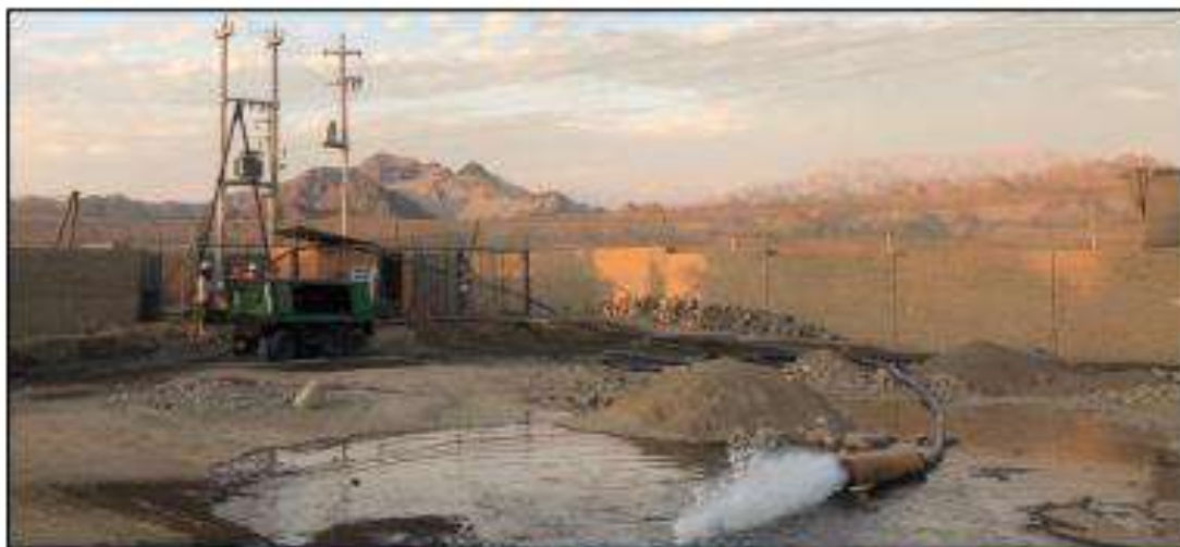
Vista de los trabajos de mantenimiento del pozo tubular #46
