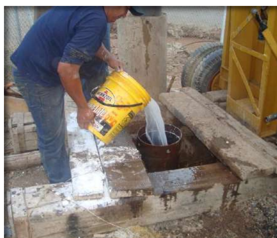
Aplicación de tripolifosfato de Na
