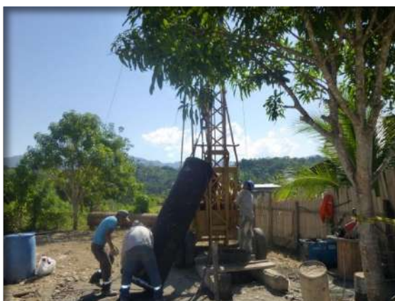
Colocación de la tubería de herramienta de 24"Ø
