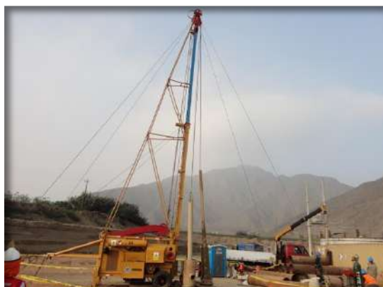
Perforación del pozo tubular
