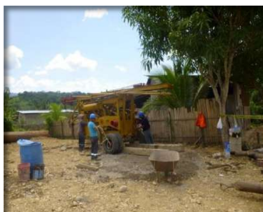
Instalación de la máquina perforadora Bucyrus Erie 24-L
