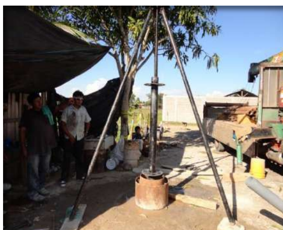
Prueba de verticalidad y alineamiento del pozo
