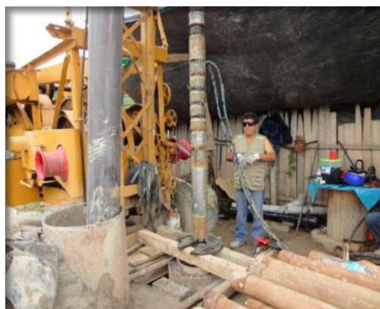
Instalación de la electrobomba sumergible
