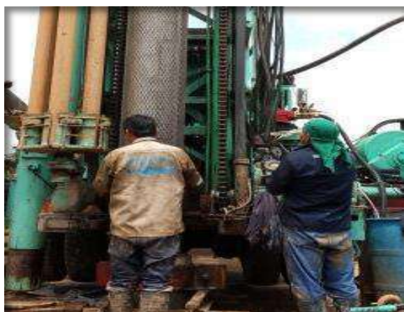
Instalación de la columna de producción de 15"Ø
