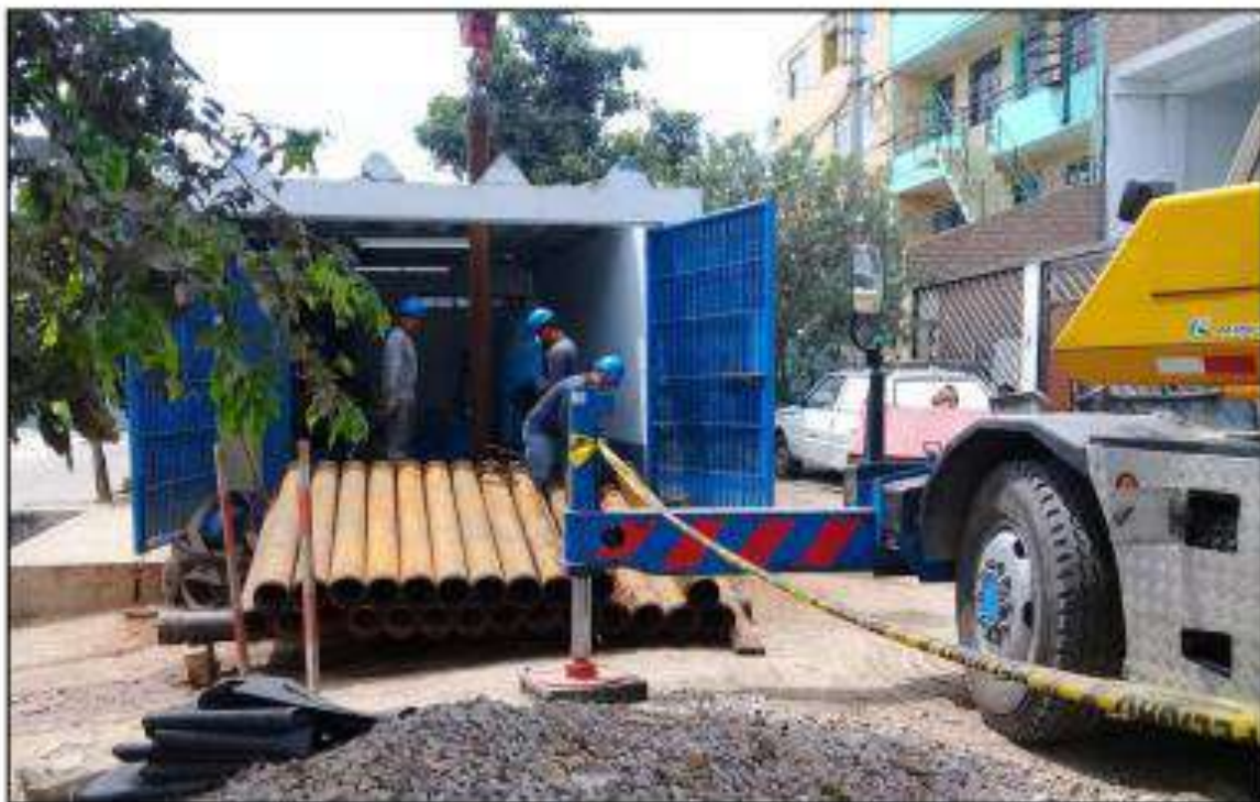
Vista de los trabajos de mantenimiento y aforo de pozo tubular
