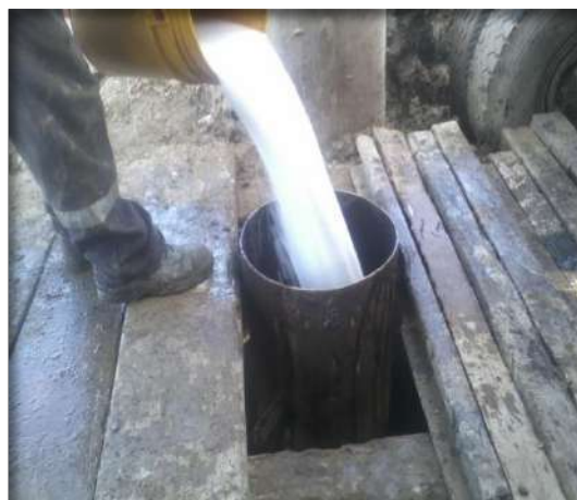
Aplicación de tripolifosfato de Na
