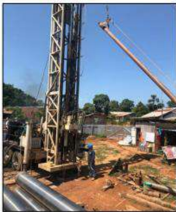
Vista de los trabajos de Perforación del pozo tubular
