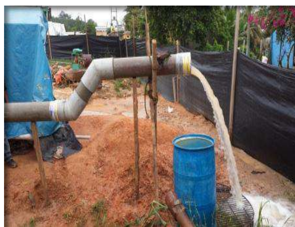
Prueba de rendimiento del pozo tubular
