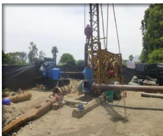
Prueba de bombeo del pozo tubular Chuín N°03
