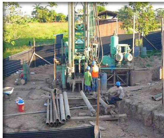
Perforación del pozo tubular con la maquina Chicago Pneumatic WS650
