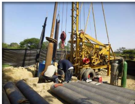
Instalación de la tubería de producción de 15"Ø
