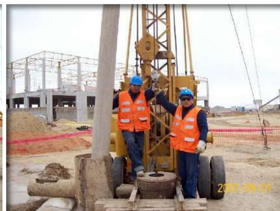
Perforación del pozo tubular
