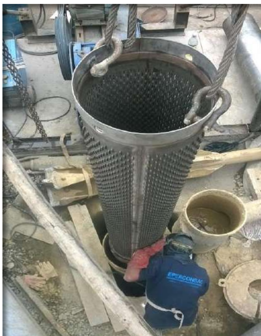
Entubado del pozo tubular
