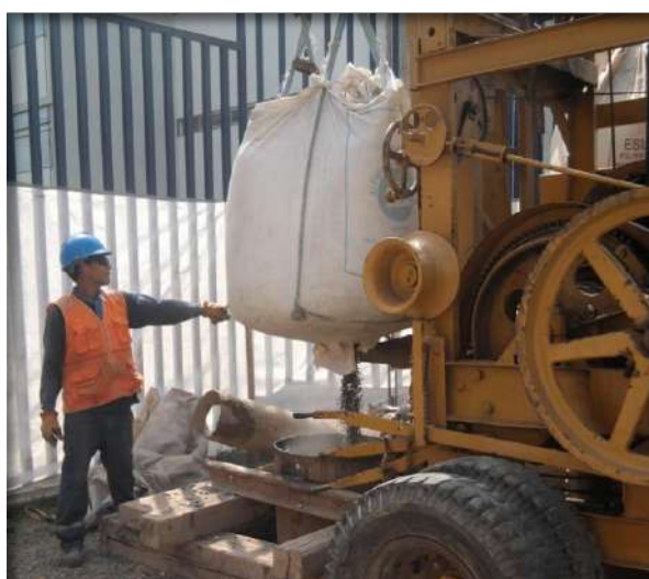
Engravado del pozo tubular
