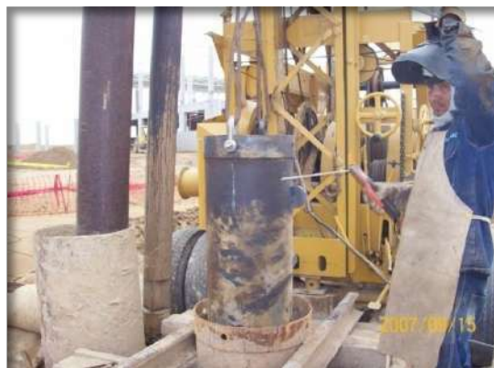
Instalación de la tubería de producción de 15"Ø
