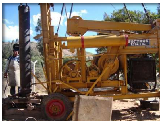
Instalación de la columna de producción de 12"Ø
