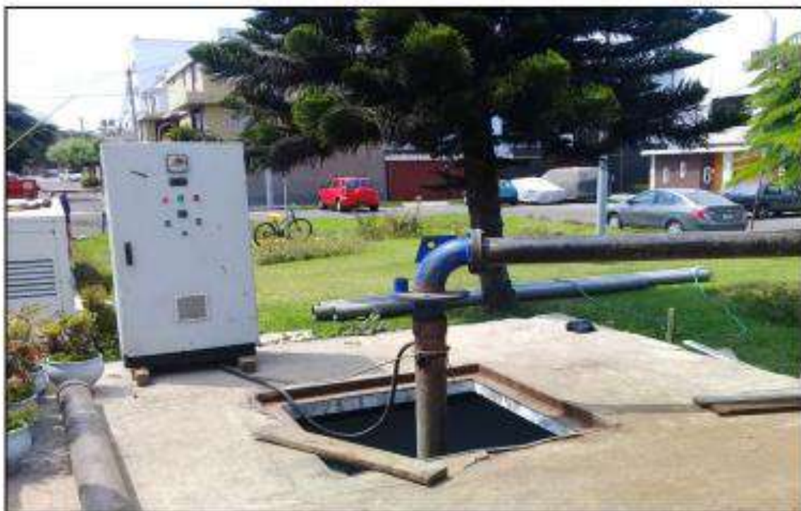
Vista de los trabajos de bombeo del pozo tubular
