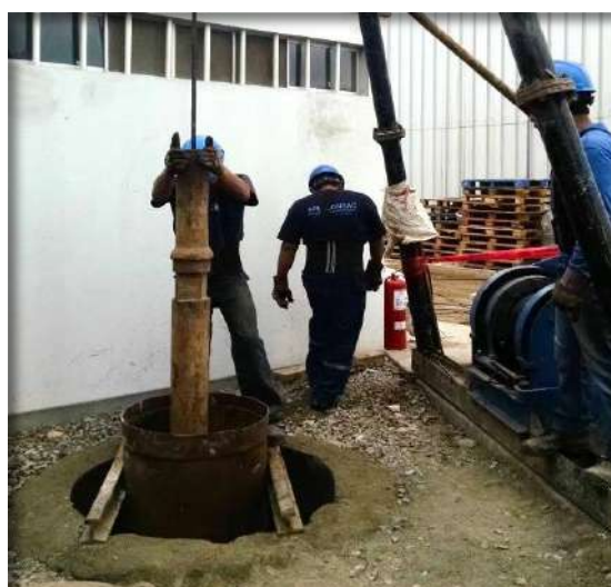
Perforación del pozo tubular Tigo SAC
