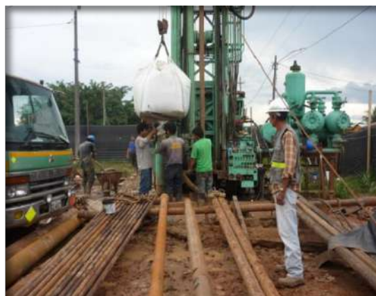
Engravado del pozo tubular
