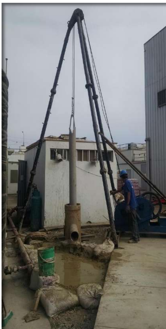
Perforación del pozo tubular Tigo SAC
