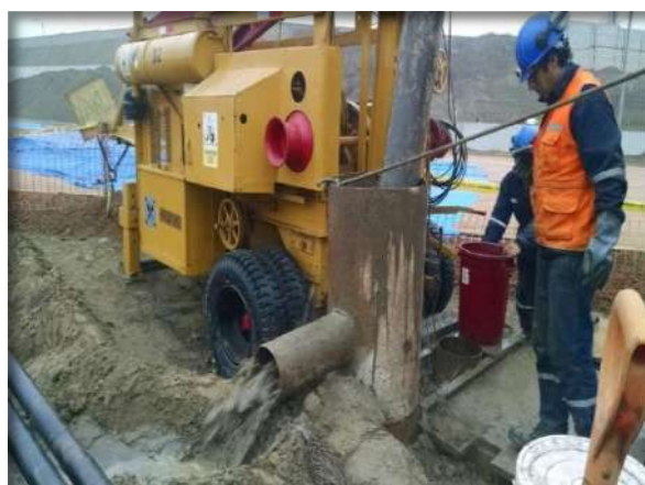
Limpieza del pozo por el método de pistoneo
