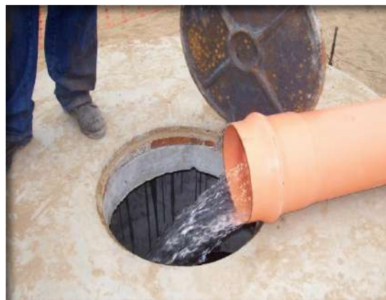
Caudal de rendimiento del pozo
