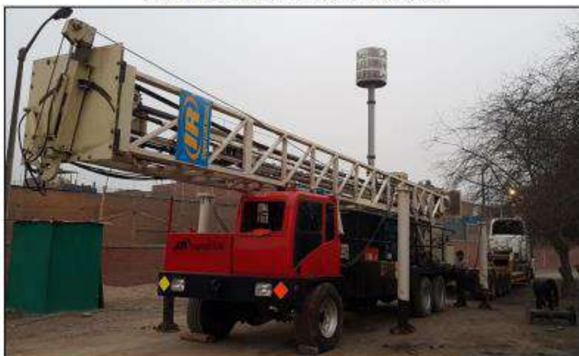
Vista de los trabajos de Perforación del pozo
