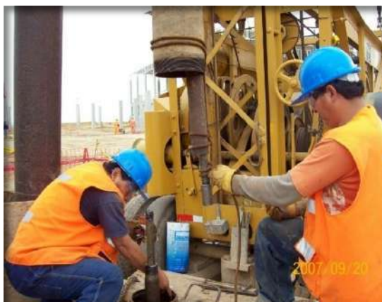
Instalación de la bomba de eje vertical de 8"Ø
