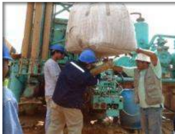
Engravado del pozo tubular
