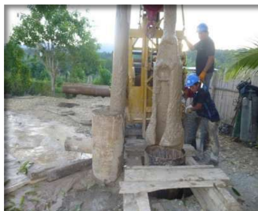
Perforación del pozo tubular
