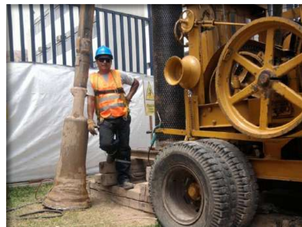
Instalación de la columna de producción de 15"Ø
