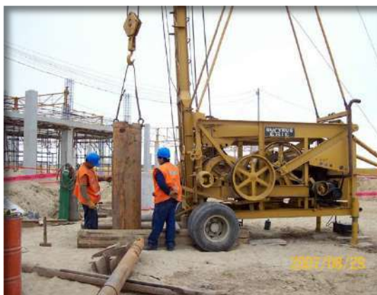
Colocación de la tubería de herramienta de 21"Ø
