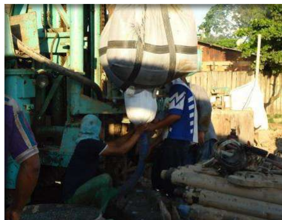
Engravado del pozo tubular
