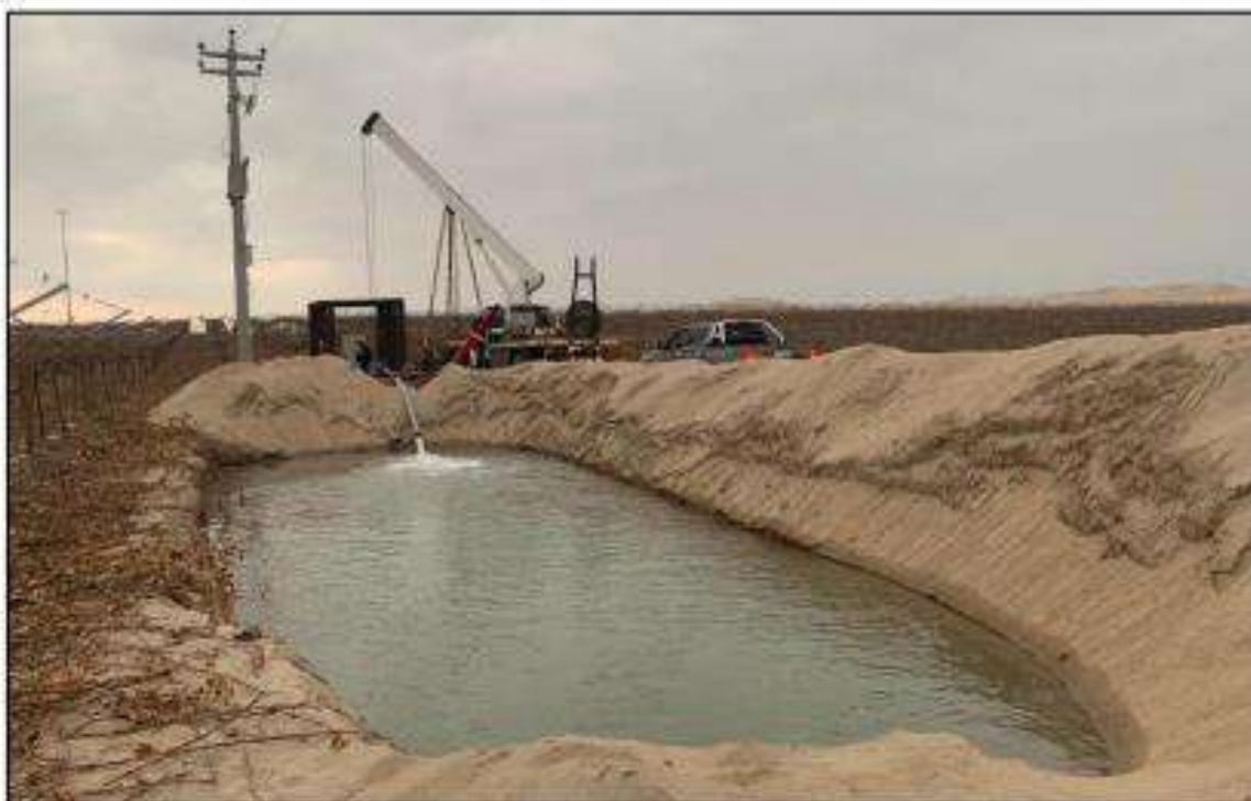
Vista de los trabajos de prueba de bombeo del pozo tubular # 12
