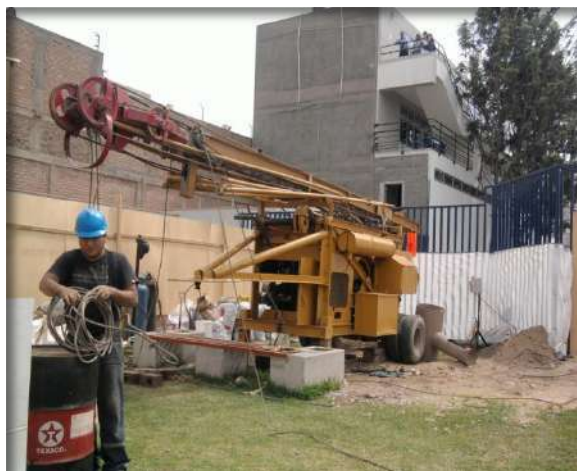
Instalación de la máquina perforadora Bucyrus Erie 60-L
