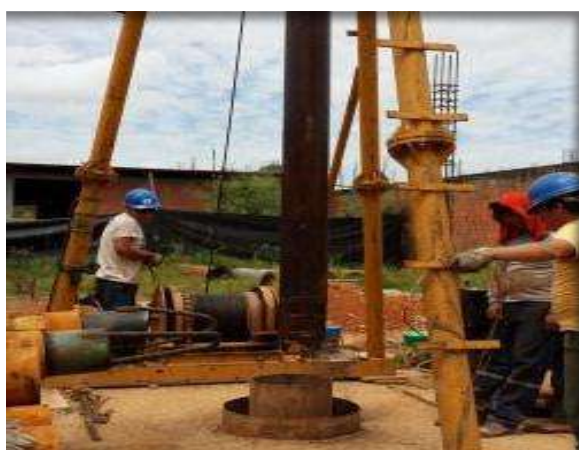
Limpieza del pozo por el método de pistoneo
