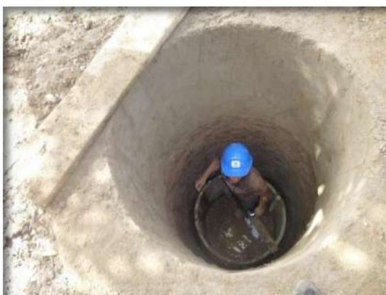
Construcción del antepozo de 1.20 m de Diámetro e instalación de anillos de concreto
