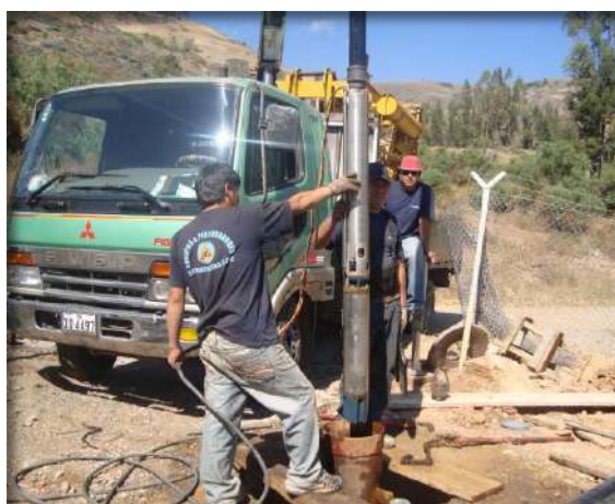
Instalación de la bomba sumergible
