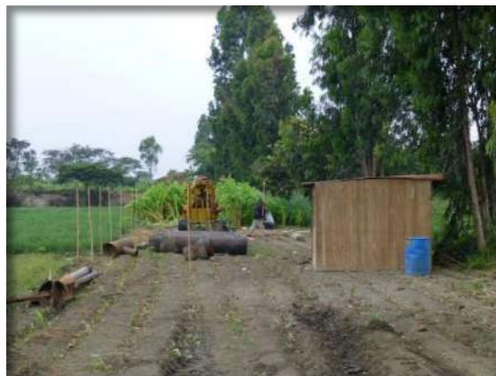
Instalación de la máquina perforadora Bucyrus Erie 24-L
