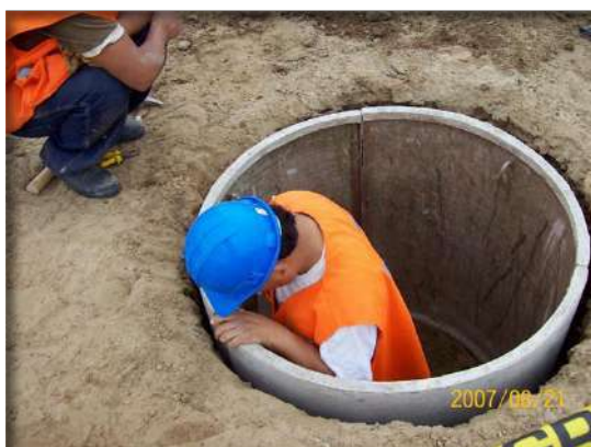
Construcción del antepozo de 1.20 m de Diámetro e instalación de anillos de concreto
