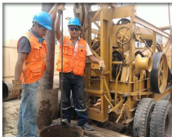
Perforación del pozo
