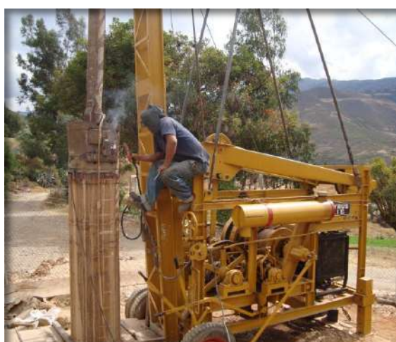
Extracción de la tubería de herramienta de 21"Ø
