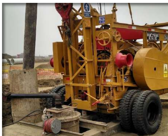
Instalación del equipo de bombeo
