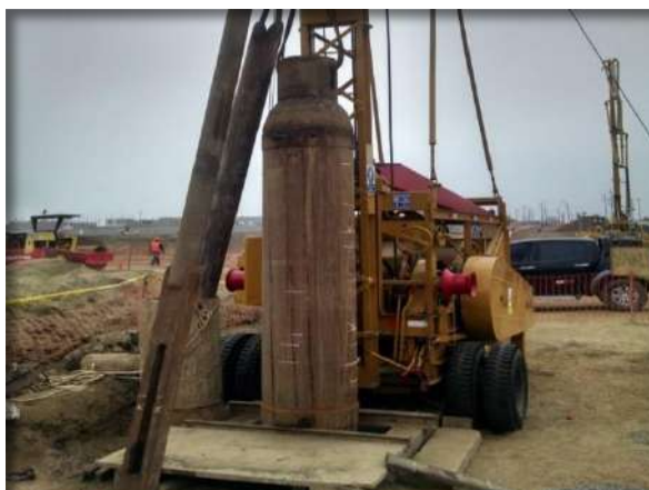
Extracción de la tubería de herramienta
