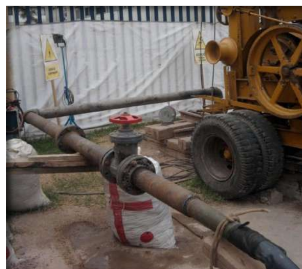
Prueba de bombeo del pozo
