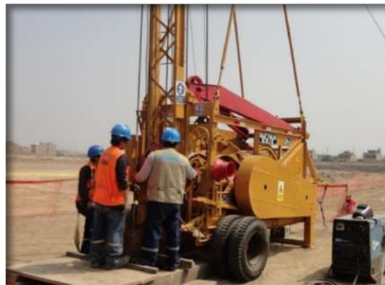
Instalación de la máquina perforadora Bucyrus Erie 60-L
