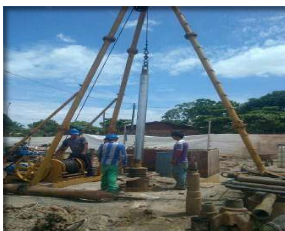
Limpieza del pozo por el método de pistoneo
