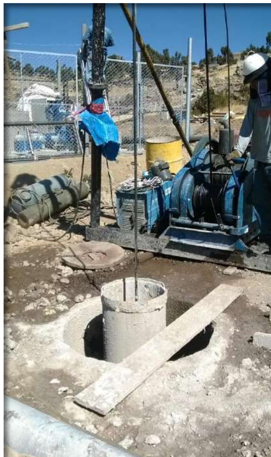
Perforación del pozo tubular isla Amantani
