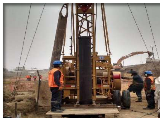
Instalación de la columna de producción
