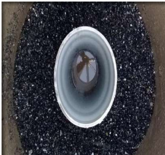
Engravado y pistoneo del pozo
