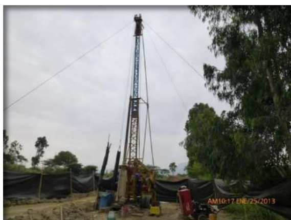
Perforación del pozo tubular
