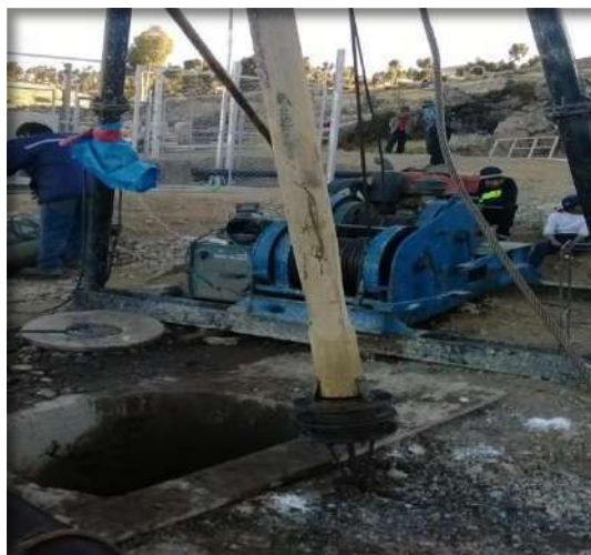
Engravado y pistoneo del pozo
