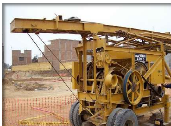
Instalación de la máquina perforadora Bucyrus Erie L 60
