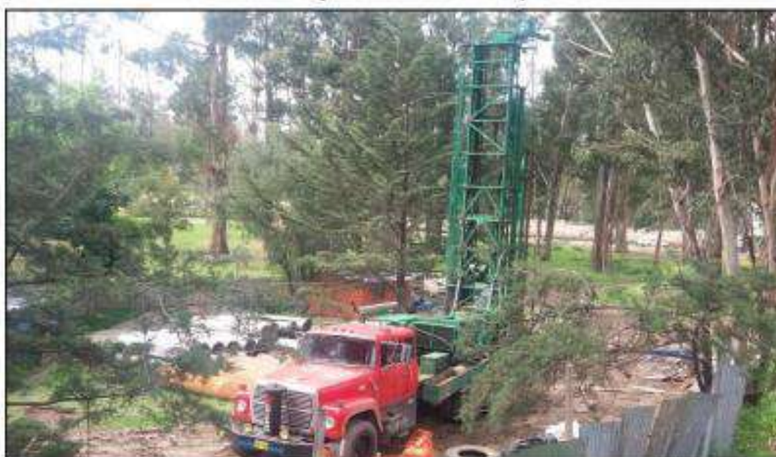
Vista de los trabajos de Perforación del pozo tubular
