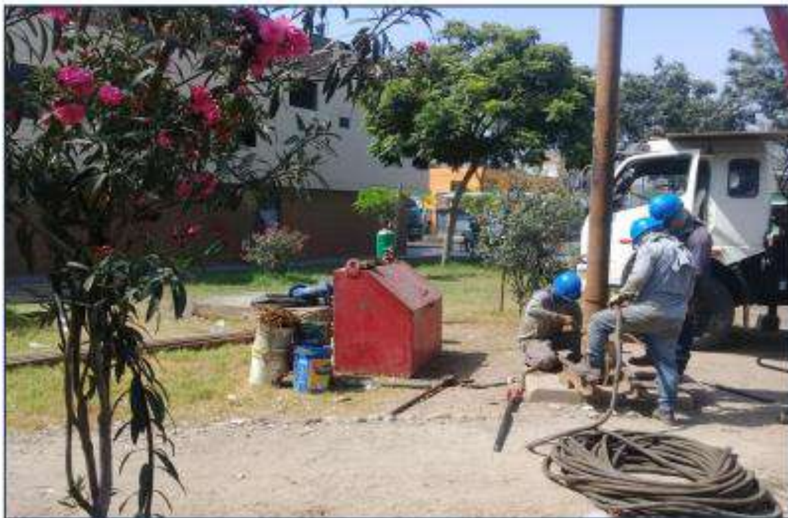
Vista de los trabajos de mantenimiento y aforo de pozo tubular
