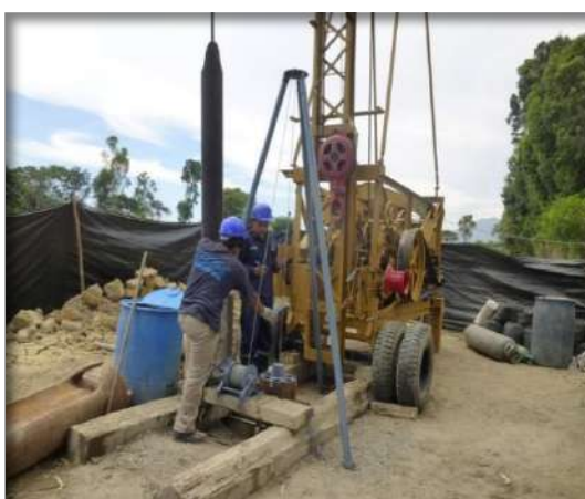
Prueba de verticalidad y alinamiento del pozo tubular Chuín N°03
