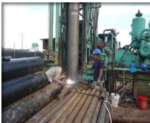
Instalación de la columna de producción de
