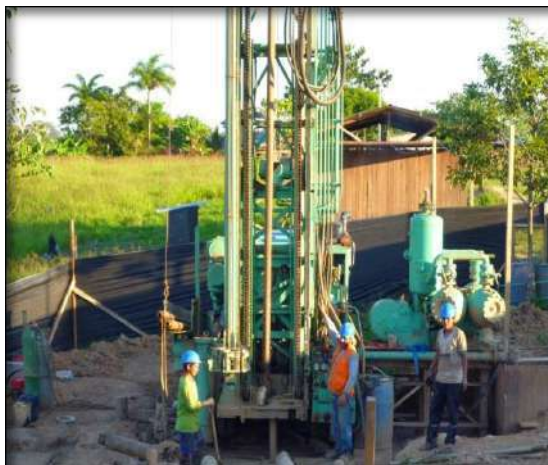
Perforación del pozo tubular con la maquina Chicago Pneumatic WS650
