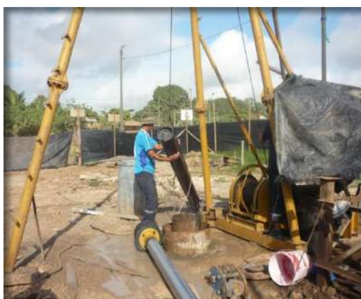
Instalación de la columna de producción de
