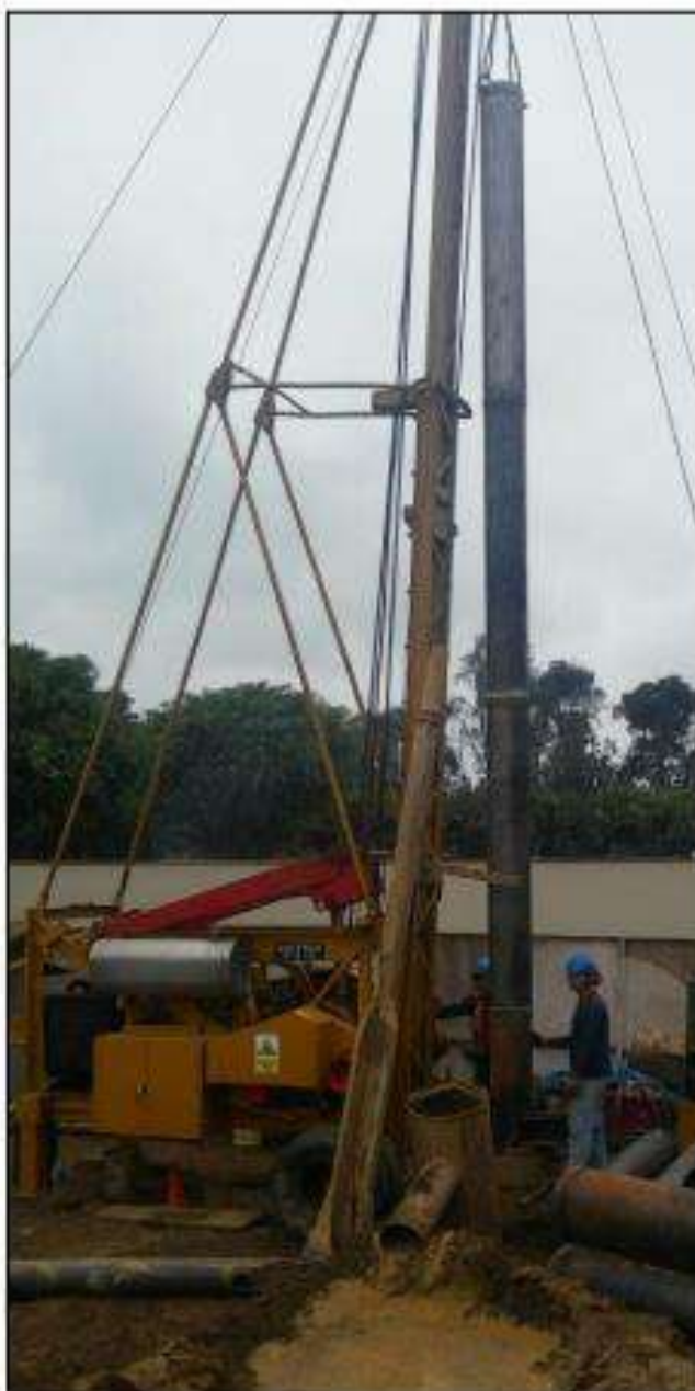
Vista de los trabajos de perforación del pozo tubular
