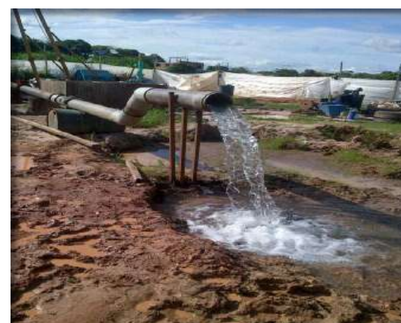
Prueba de rendimiento del pozo tubular
