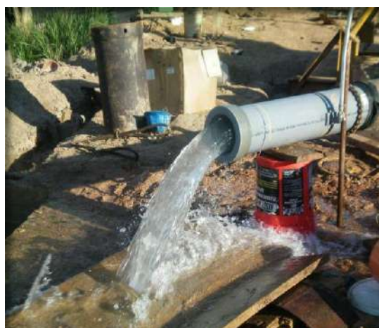
Prueba de rendimiento del pozo tubular
